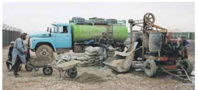
Sidst i februar kan Forsvarets Bygnings- og Etablissemestjeneste aflevere et radarfundament og øvrige faciliteter for den meget omtalte radar ved Mazar-e-Sharif i Afghanistan. Det havde været en udfordring at arbejde med den afghanske entreprenør, som har helt andre arbejdsgange. ▼
