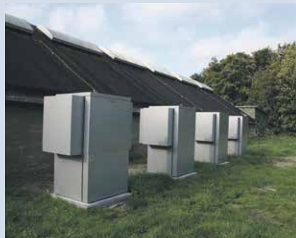
De ligner store futuristiske køleskabe, men de nye varmepumper skåner miljøet og holder personellet varmt. Foto: Martin Særmark-Thomsen
