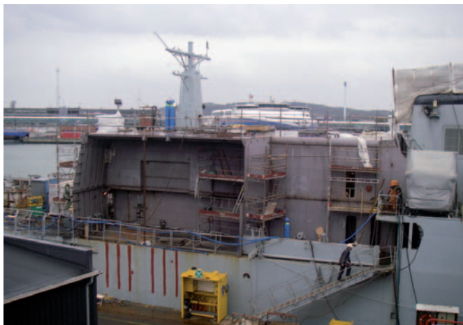
Vædderen under ombygning på Orskov Yard. Foto: FMI
