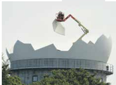
Montering af kuplen Foto: FLVFOT Jan Kjær/Lars Richter
